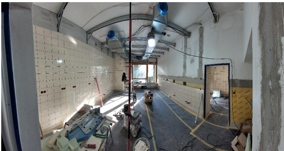
Work in Progress - Alles wird hell gefliest und durchdacht aufgebaut.
