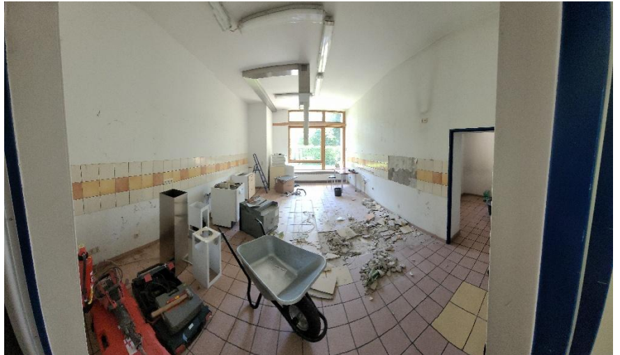
Abriss der alten Küche. 30 Jahre gute Dienste geleistet – jetzt ist Abbruch angesagt.
